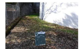
9.資材撤去完了
